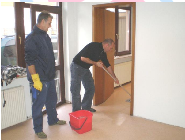
Am Ende der Renovierungsarbeiten wurde der inzwischen in die Jahre gekommene Bodenbelag gereinigt und versiegelt.
