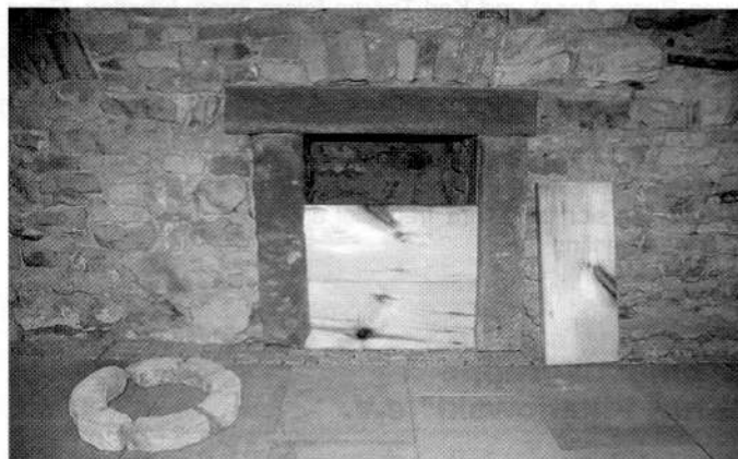
Teilgeöffneter Lüftungsschacht und Reste eines ursprünglichen Außenschachtes
